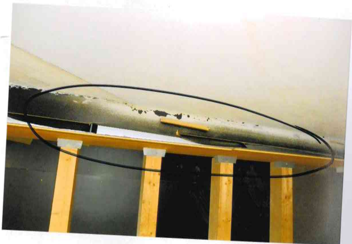
Zbliżenie osadzenia słupów drewnianych na poddaszu.
