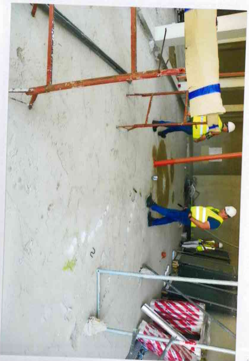
Ściana działowa niedopuszczalnie osłabiona otworami pod instalacje sanitarne.
