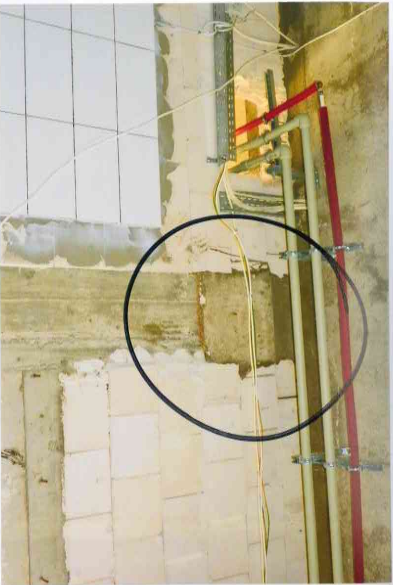
Zbliżenie wadliwego wykonawstwa elementów żelbetowych na parterze budynku.
