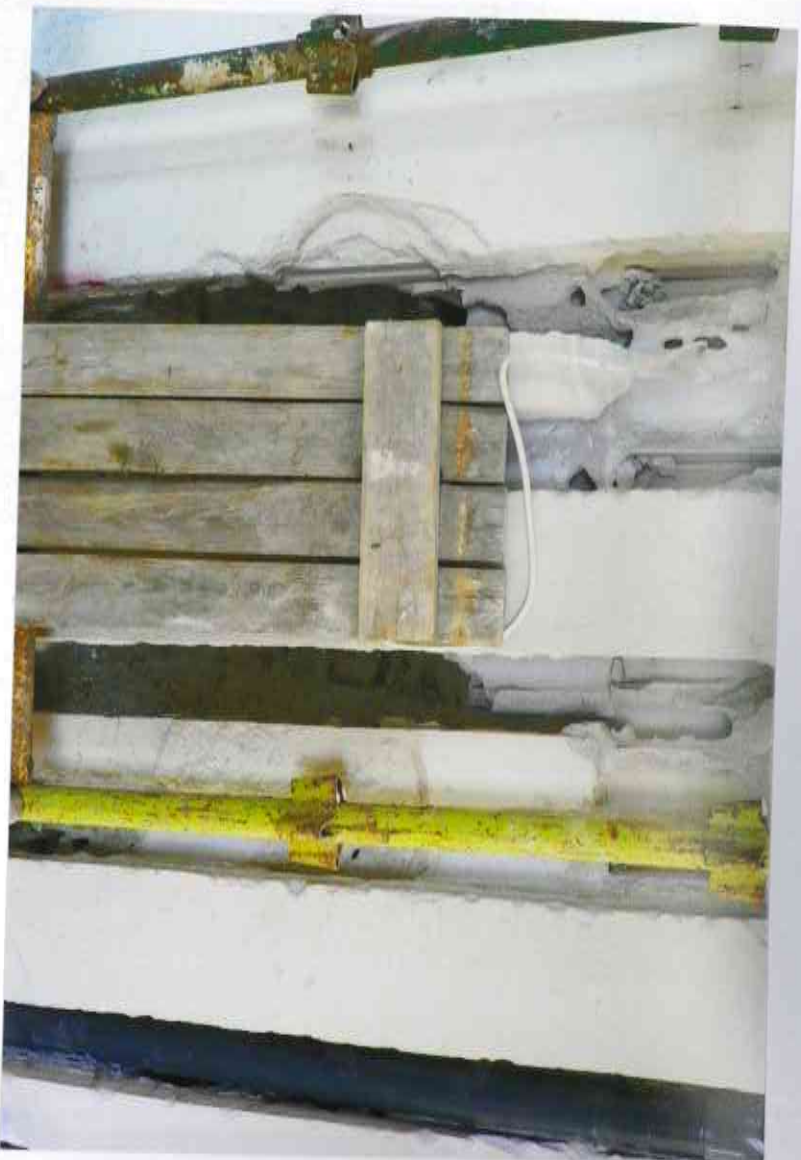
Ściana działowa niedopuszczalnie osłabiona otworami pod instalacje sanitarne.
