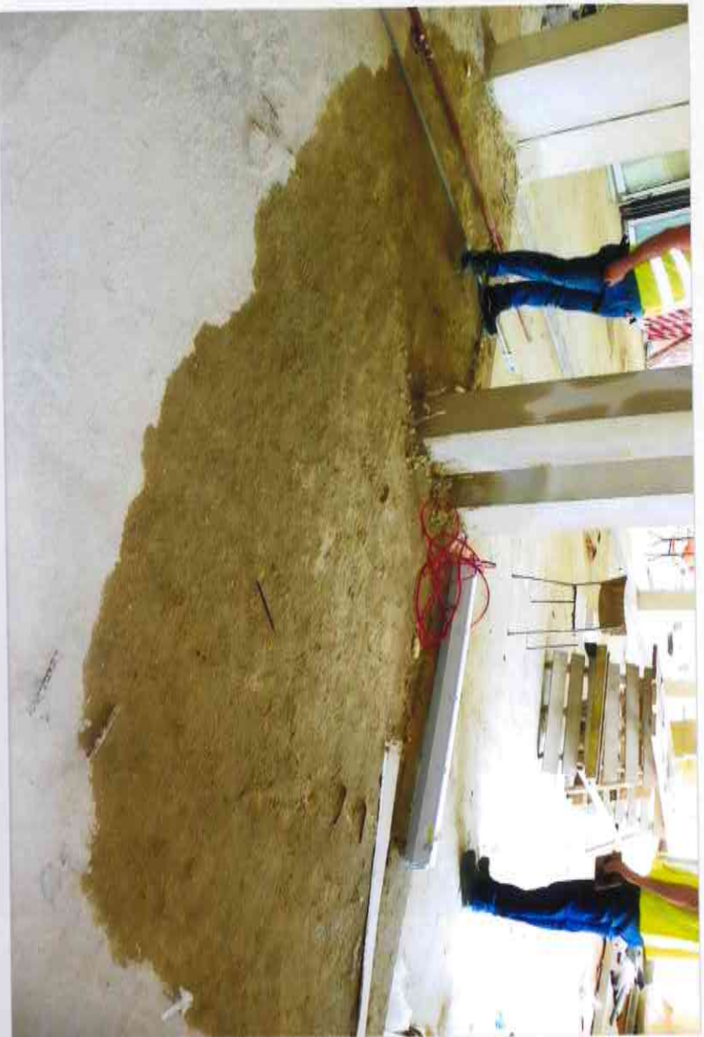
Zbliżenie wadliwego wykonawstwa elementów żelbetowych na parterze budynku.
