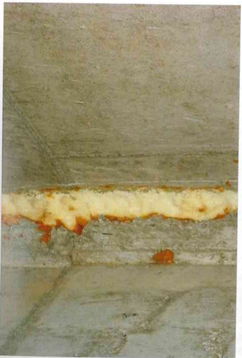
Próba " doszczelnienia " narożnika pianką poliuretanową.
