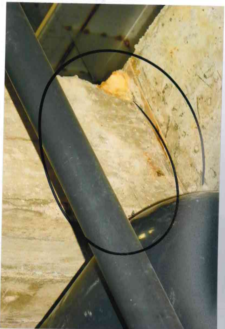
Zbliżenia wadliwego przygotowania deskowania stropu i ścian.
