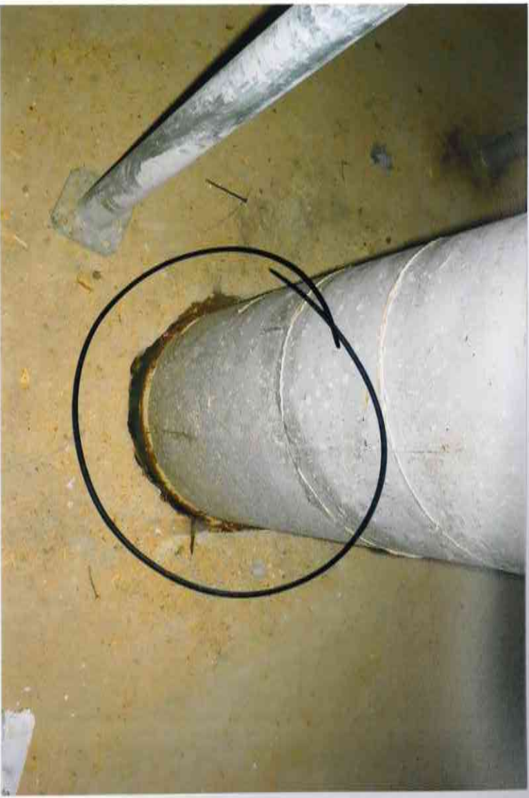
Brak możliwości zweryfikowania osadzenia słupów w stopach.
