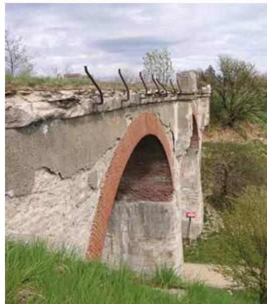
Zabytkowy wiadukt na drodze do Kiepojci
