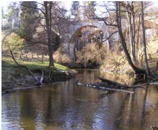
Zabytkowe mosty kolejowe na Jarce
